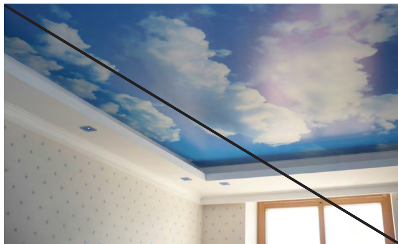
Плохо Натяжные потолки. Потолки с рисунками
